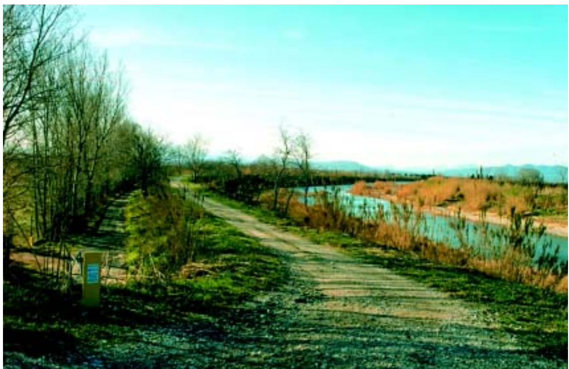
Photo 5.2 – La piste de service en crête – ici localement doublée d'une piste en pied de digue côté val – facilite les opérations de surveillance des digues de l'Agly.
