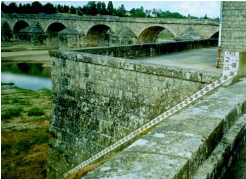
Photo 1.4 – Mur de quai en maçonnerie en rive gauche de la Loire à Gien (Loiret). Échelle limnimétrique avec repère de crue.
