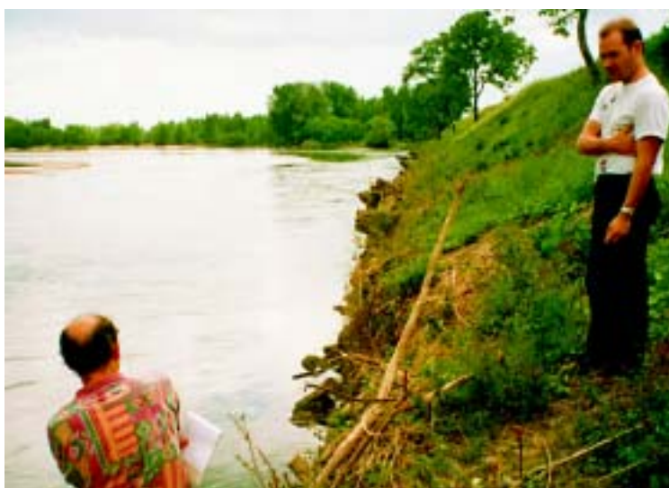
Photo 2.5 – Pied de berge affouillé en contrebas de la levée d'Espagne à la Charité-sur-Loire.
