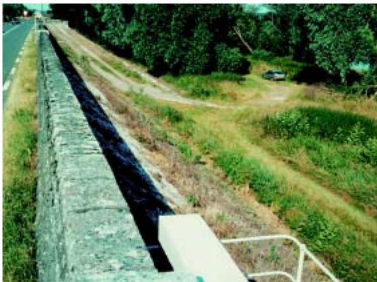
Photo 2.17 (Cemagref, Rémy Tourment) – Banquette de rehausse en maçonnerie de pierres, côté fleuve du couronnement de la levée du Val de Cisse (Indre-et-Loire). Au second plan, rampe d'accès au fleuve.
