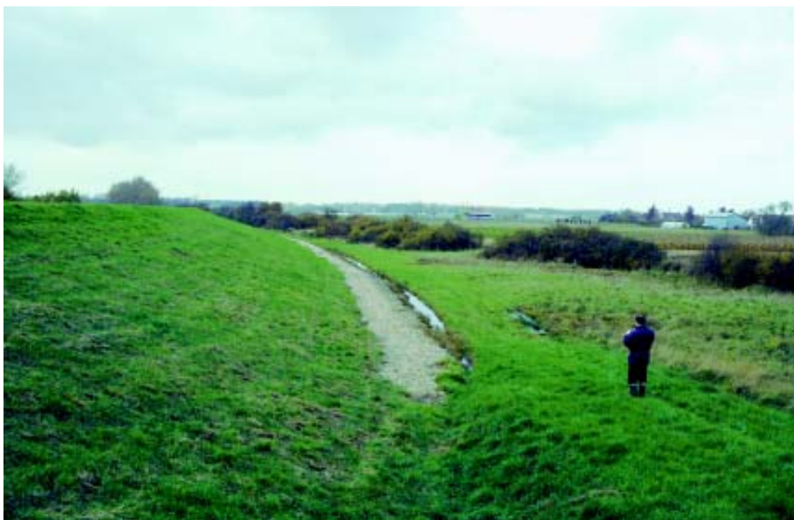
Photo 6.7 – Engraissement du talus côté val sur tapis drainant : levée du Val de Bou.
