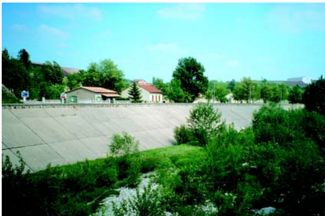
Photo 1.6 – Aménagement de 1958 du Gardon d'Alès dans sa traversée de la ville d'Alès (Gard) : protection de la berge par dalles bétonnées n'ayant que localement la fonction de digue.
