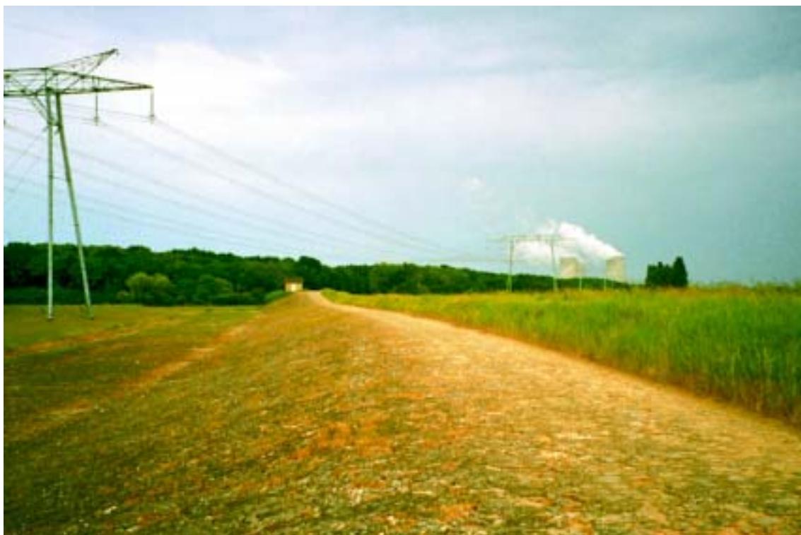
Photo 1.7 – Déversoir en maçonnerie de pierres d'Ouzoueur-sur-Loire (Loiret), équipé d'une banquette fusible (cordon de terre enherbé, à droite sur la photo).
