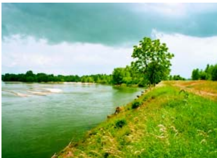
Photo 2.4 – Pied de digue en contact avec le lit mineur de la Loire, dans une courbe concave, sur la levée d'Espagne à la Charité-sur-Loire (Nièvre).
