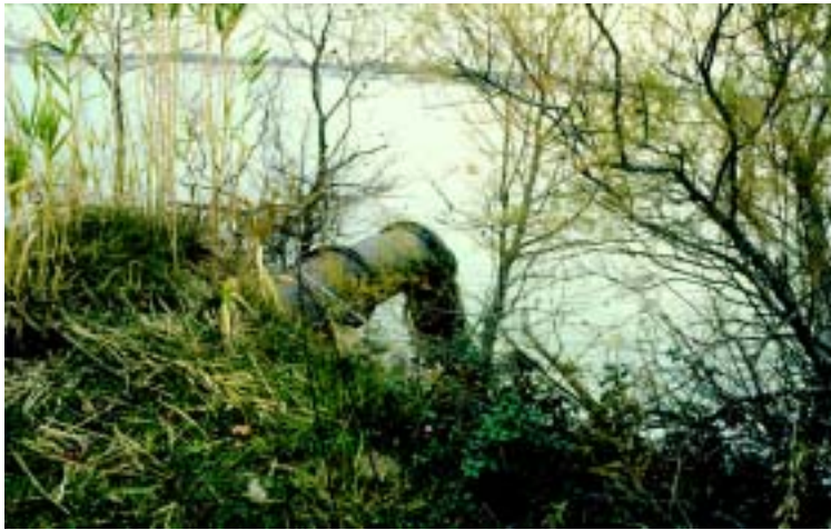
Photo 3.13 – Les passages de canalisation (ici conduite de pompage dans le Grand-Rhône) sont des points à examiner particulièrement lors des inspections.
