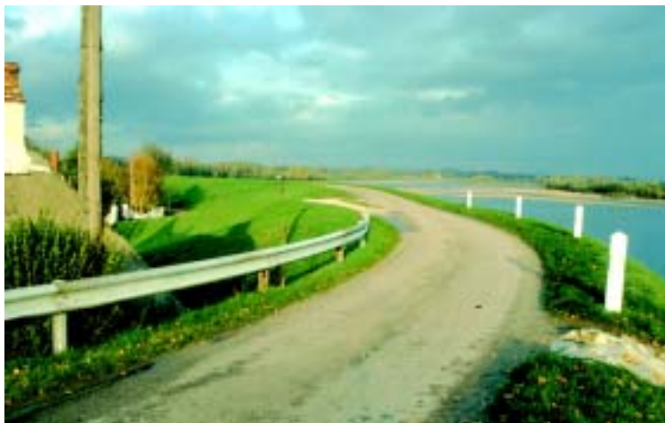
Photo 3.15 – Secteur d'étroitesse du profil de la levée du Bal de Bou en rive droite de la Loire, dû à la présence d'une habitation côté val : un point de faiblesse potentielle à surveiller en crue.
