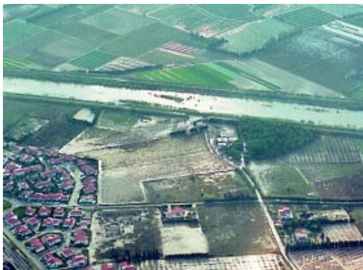
Photo 2.1 (auteur : Frédéric Hédelin) - Vue aérienne de la brèche par surverse de St-Laurent-de-la-Salanque sur la digue rive gauche de l'Agly, suite à la crue des 12-13/11/1999. La malchance a voulu que la brèche se produise juste au droit de la station d'épuration. Les quartiers menacés de la localité avaient fort heureusement été évacués.
