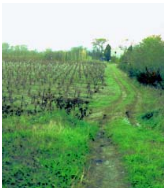
Photo 3.3 – Inspection post-crue de la digue de Cuxac-d'Aude : points bas en crête (passage de chemin) ayant surversé.
