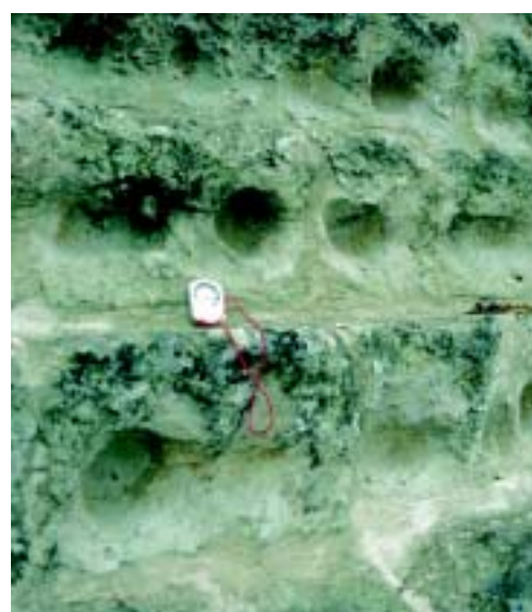
Photo 3.20 – Les pierres de maçonnerie de tuffeau (matériau souvent utilisé en vals de Loire) sont sensibles au phénomène de dissolution.
