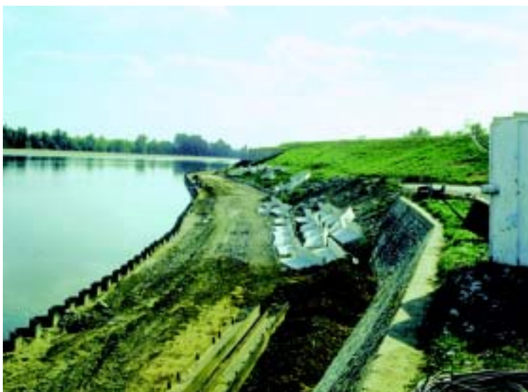
Photo 6.10 – Protection en construction du pied de talus côté fleuve sur la levée du Val de Bou.
