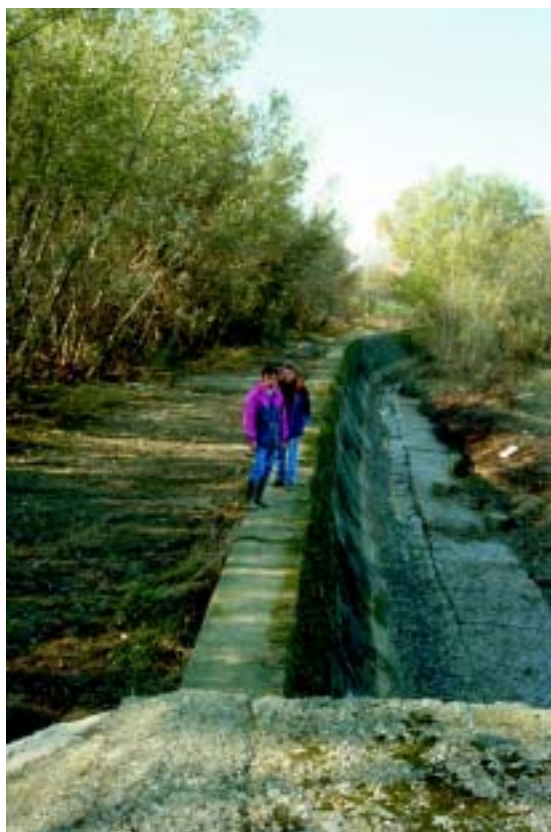
Photo 1.8 – Déversoir en béton sur la digue rive gauche de l'Aude à Cuxac-d'Aude.
