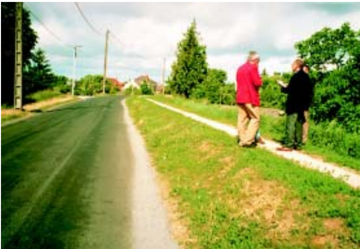
Photo 6.13 – Banquette de rehausse côté fleuve et corps de digue confortés par rideau de palplanches sur la levée de Jargeau (Loiret).
