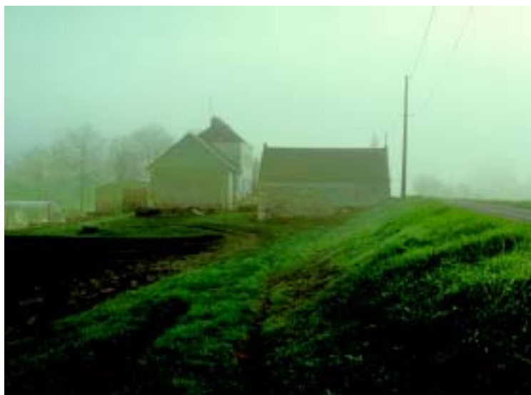
Photo 1.9 – Bâtiment encastré dans le talus côté val de la levée du Cher à Savonnières (Indre-et-Loire).
