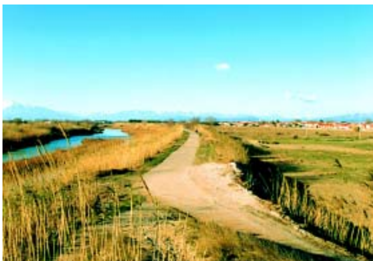
Photo 2.3 - Zone localisée de surverse réparée côté val sur la digue rive gauche de l'Agly à St-Laurent-de-la-Salanque, suite aux dégâts de la crue des 12-13/11/1999.
