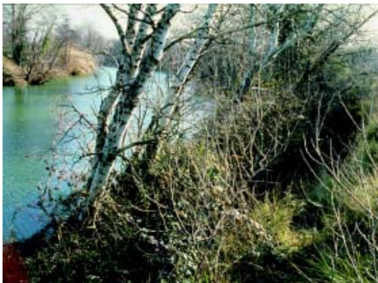
Photo 2.14 - Pied de berge glissé sur une digue du Vidourle (Hérault) comme en témoignent les arbres inclinés.
