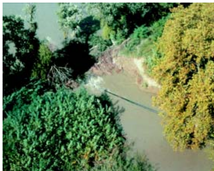
Photo 2.12 (source : Service Navigation Rhône-Saône) - Vue aérienne d'une brèche de digue de Camargue au droit d'un passage de canalisation.
