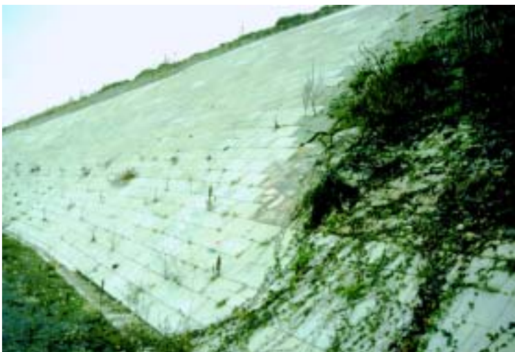
Photo 6.14 – Perré côté fleuve réparé avec des éléments préfabriqués, sur la levée du Val d'Authion.
