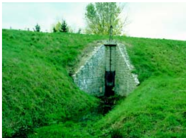
Photo 1.10 – Ouvrage de traversée batardable dans la levée de la Loire au Val de Bou (Loiret), vu côté val.
