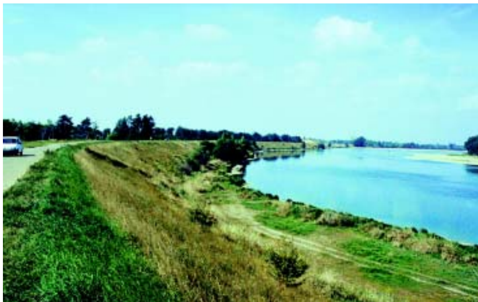
Photo 1.1 – Allure typique d'une levée de la Loire Moyenne : digue en remblai, profil large, talus enherbés et voie de circulation en crête.
