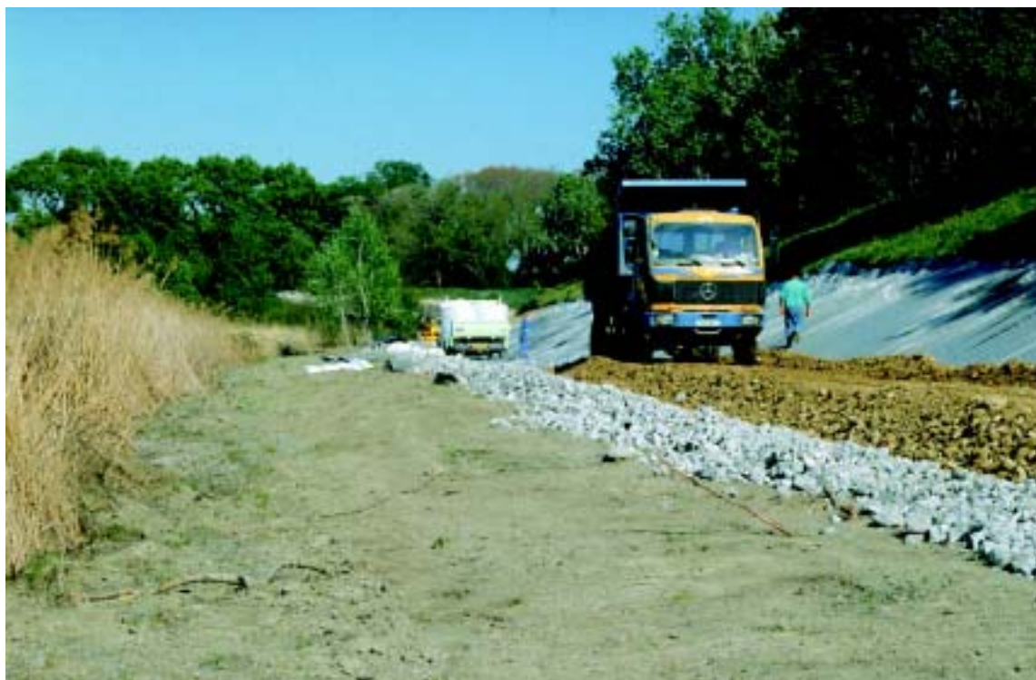
Photo 6.8 – Construction en urgence d'une recharge aval drainante en pied du talus côté val de la digue du Petit Rhône après la crue du 8 janvier 1994.
