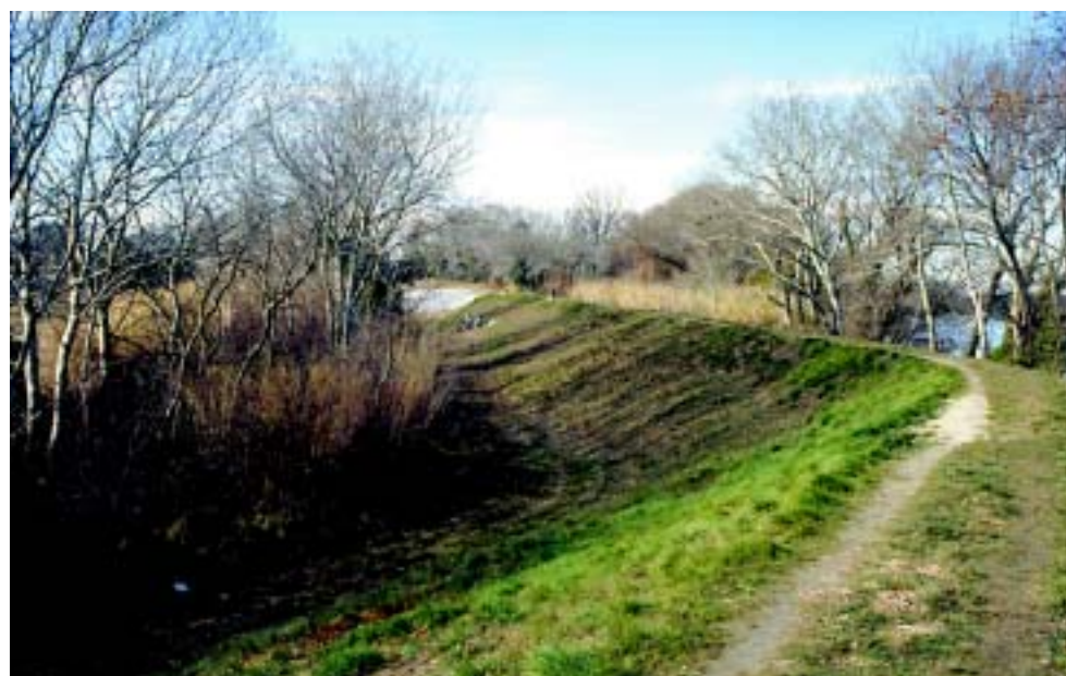
Photo 1.2 – Digue en remblai du Petit Rhône en Camargue (Bouches-du-Rhône). Profil avant travaux de confortement de 1994 : crête étroite ne permettant pas la circulation d'engins mécaniques.
